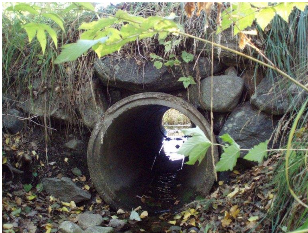
Figur 8: Befintlig vattentrumma vid Karbosjöns utlopp. Foto: WSP 2009-10-15.
