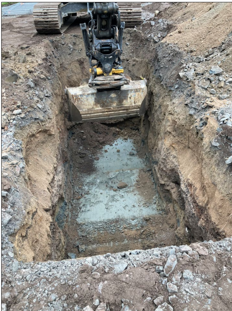
Figur 18. Schakt för den tidigare eldningsoljecisternen där förorening över NV MKM påträffades, dock med mycket begränsad spridning i det täta lerlagret (Källa: DeKa Enviro AB, 2023)
