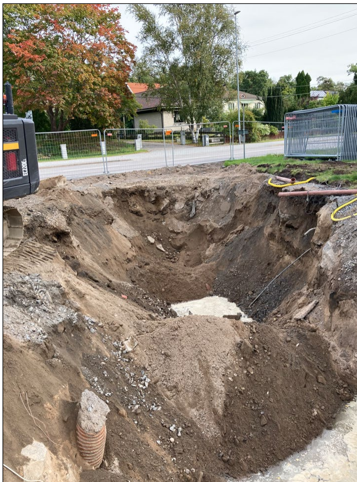
Figur 17. Schakt för cistern nr 05, där berg noterades vid ca 4 meter under markytan. Överst i bild syns Ältavägen (Källa: DeKa Enviro AB, 2023)
