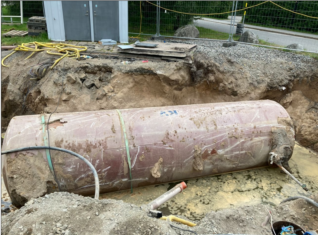
Figur 13. Fotot visar schakten för cistern nr 01, där grundvatten tryckte in vid ca 3 – 4 meters djup. Överst i bild syns databoden samt Älta Idrottsväg (Källa: DeKa Enviro AB, 2023).
