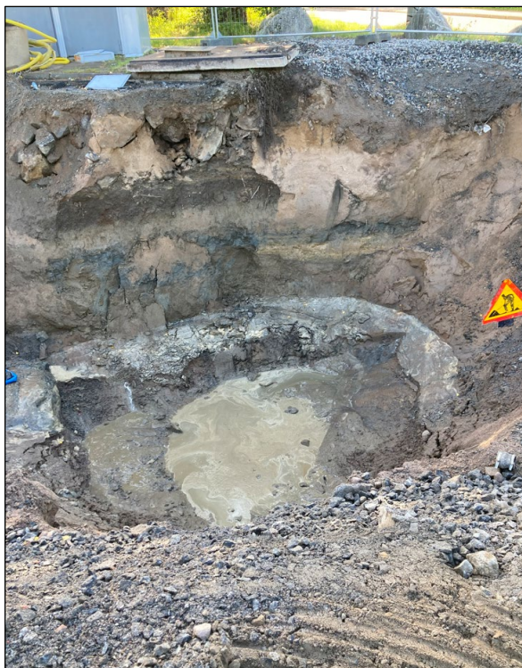
Figur 15. Schakt för cistern nr 01, där berg noterades vid ca 5 meter under markytan. Överst i bild syns Älta Idrottsväg (Källa: DeKa Enviro AB, 2023)
