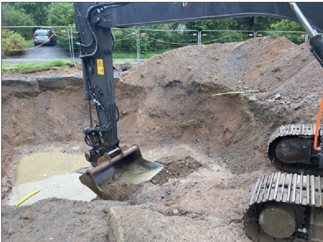
Figur 14. Fotot visar pågående provtagning i schakt för cistern nr 02-04. Överst i bild syns Älta Idrottsväg (Källa: DeKa Enviro AB, 2023).
