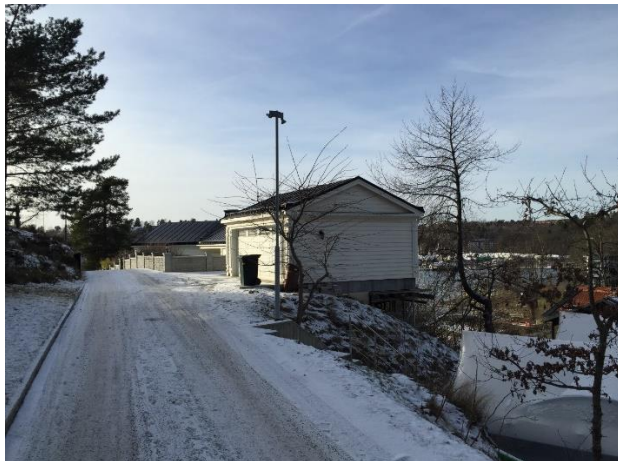
Vy över garage från Korsuddsvägen (syd)
