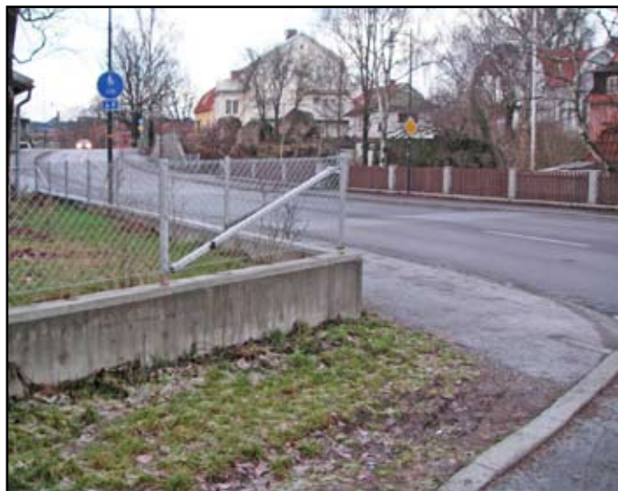
Ett stängsel i en korsning ger god sikt och är därmed bra ur trafiksäkerhetssynpunkt.
