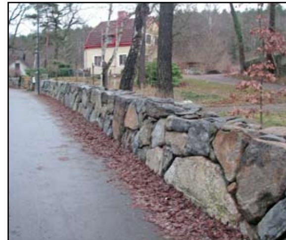
En låg mur utmed vägen.
