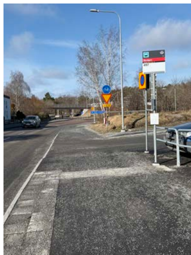
Bild 6. Hållplats Byvägen, riktning Stockholm.
