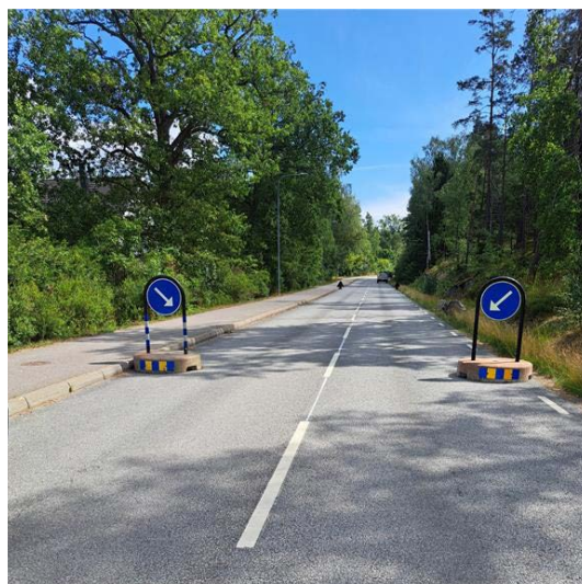
Bild 12. Betongöar placerade på Hasseluddsvägen.
