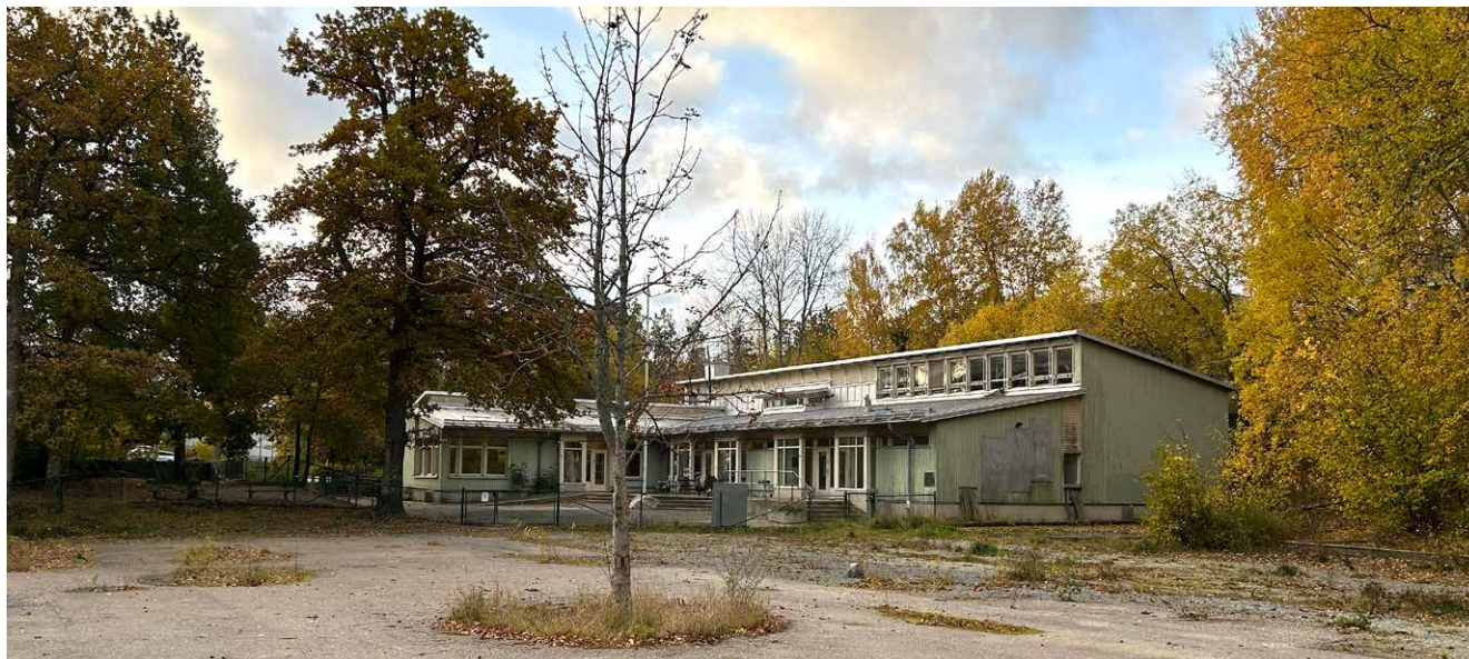
Figur 4: Befintlig byggnad inom projektområdet.
