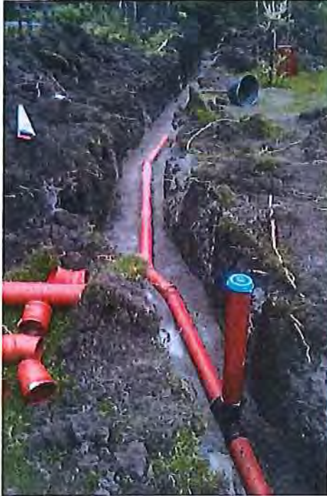
Bild 2. Dräneringsledningarna runt huset samt ner till brunnen
