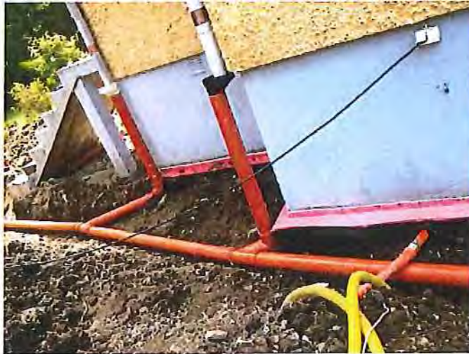
Bild 4. Dagvattenledningarna från stuprören till kassetten i gräsmattan
