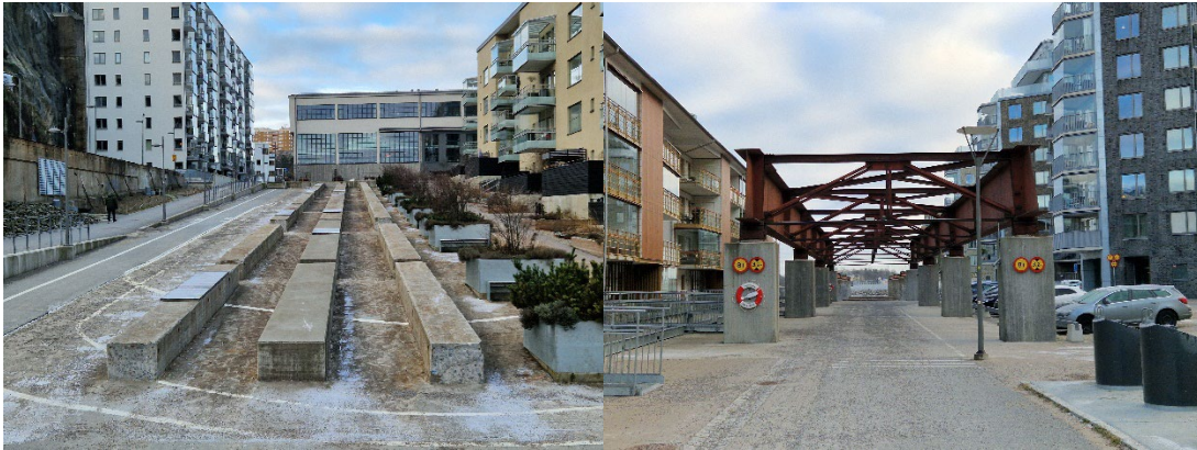
Figur 1. Bilder över industrihistoriska anläggningar. Bild till vänster visas en stapelbädd. Bild till höger visar en tidigare kranbana.
