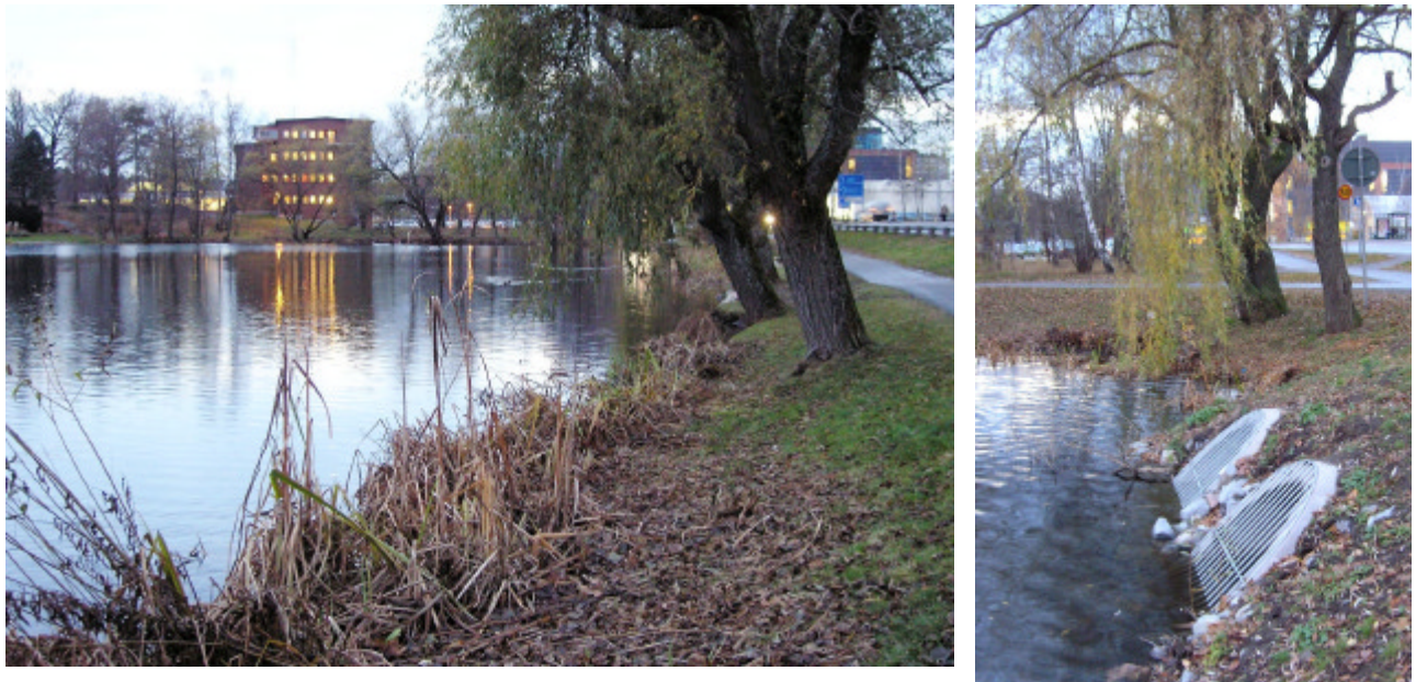
Figur 1. Kyrkvikens norra strand och de nya dagvattenledningarnas mynningar.
