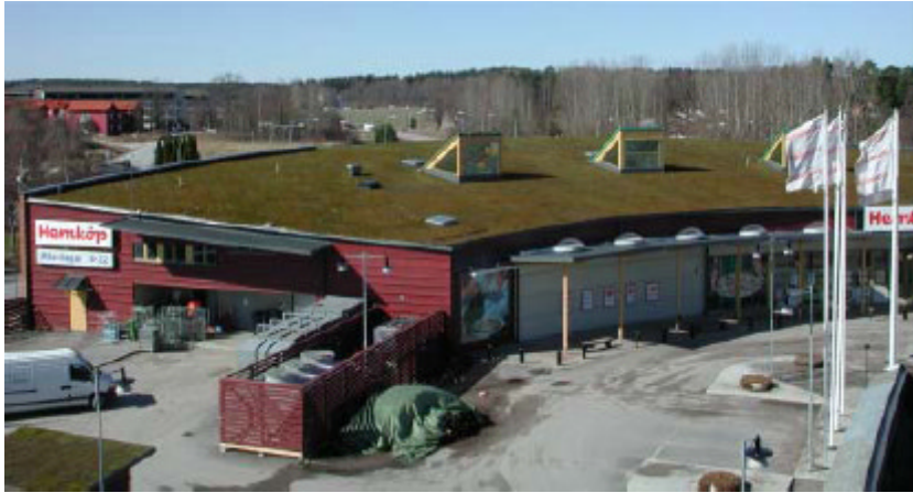
Figur 12. Exempel på ”grönt tak” på en matvaruaffär i köpcenter i Runby, Upplands Väsby. Foto: Oxunda Vattensamverkan.
