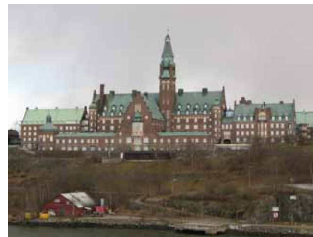
Danvikshem, äldreboende och vårdhem, ritat av arkitekt Aron Johansson och färdigställt 1915. Arkitekturen anspelar i nationalromantisk anda på vasatidens borgar, men det finns även inslag av jugend. Höga terrassmurar förankrar byggnadskroppen med den sluttande terrängen mot farleden.
