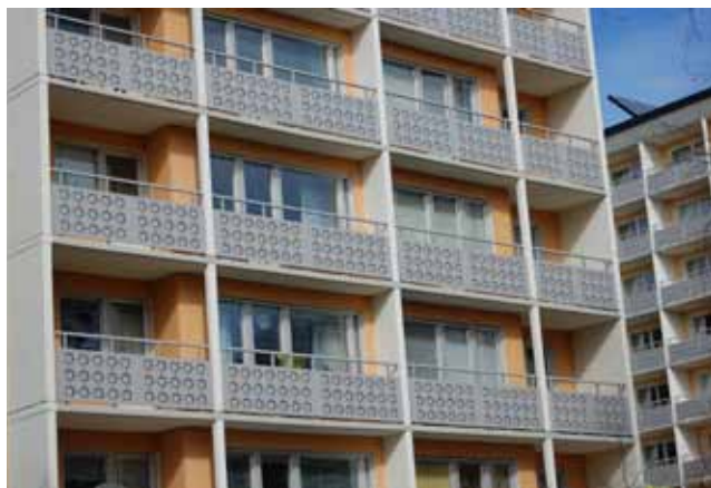
Gavlarna mot söder består genomgående av balkonger.
