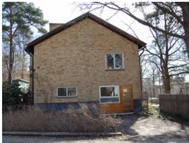
Villa med tegelfasader.
