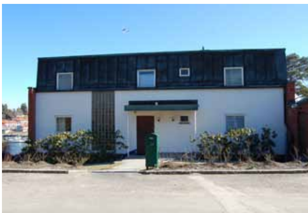
I området finns två sorters villor med material och stil som återkommer i radhusen.
