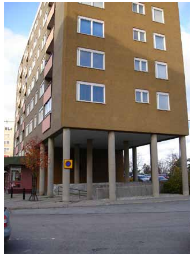
Gavelfasad stående på betongpelare.
