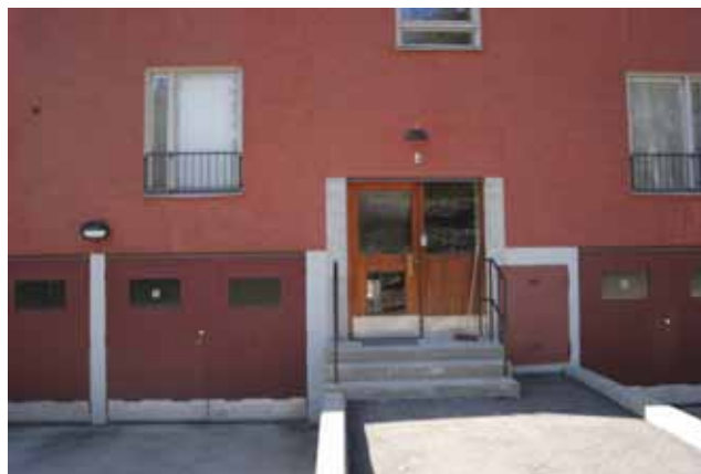
Garage i källare på lamellhuset.
