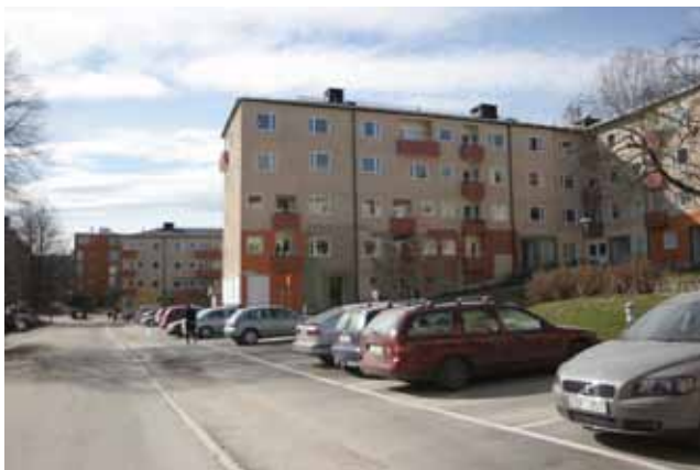
Öppna gårdar i södersluttning mot vägen.
