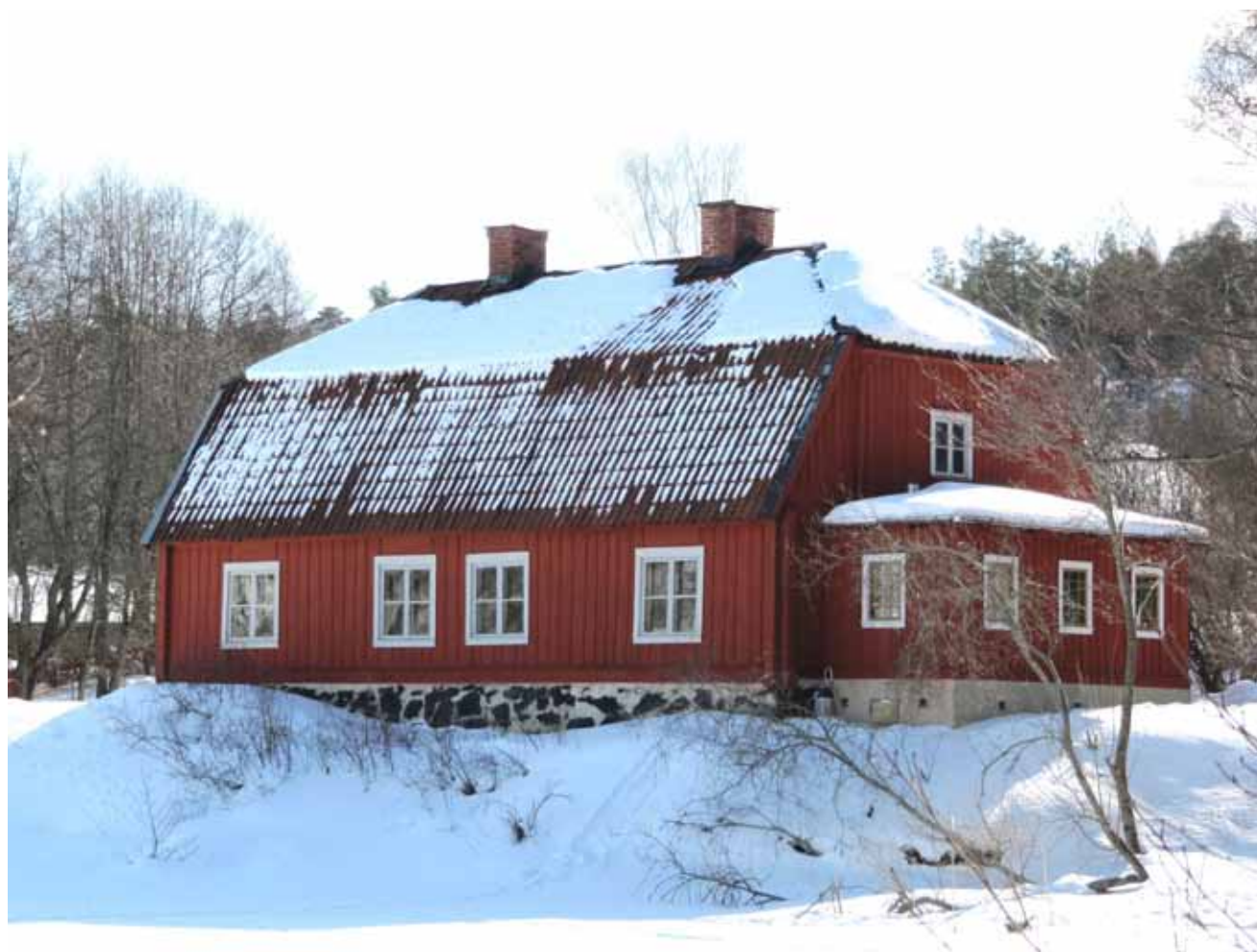
Källtorps sjöfasad. Huvudbyggnaden renoverades varsamt 2004-2006, då tillkom också gaveltillbyggnaden för våtutrymmen. Tillbyggnaden har en låg profil för att underordna sig helheten.
