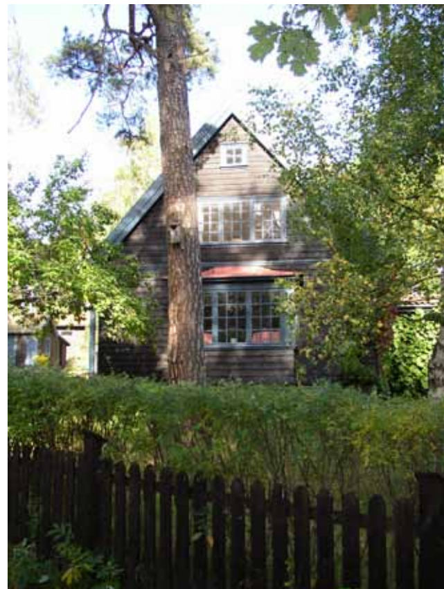
Nationalromantiskt fritidshus vid Skogsös östra strand. Den mörka färgsättningen hör till arkitekturen, det fanns en strävan till en timmerromantisk känsla även om huset fick fasadpanel. Stugan antas vara byggd så sent som 1931.
