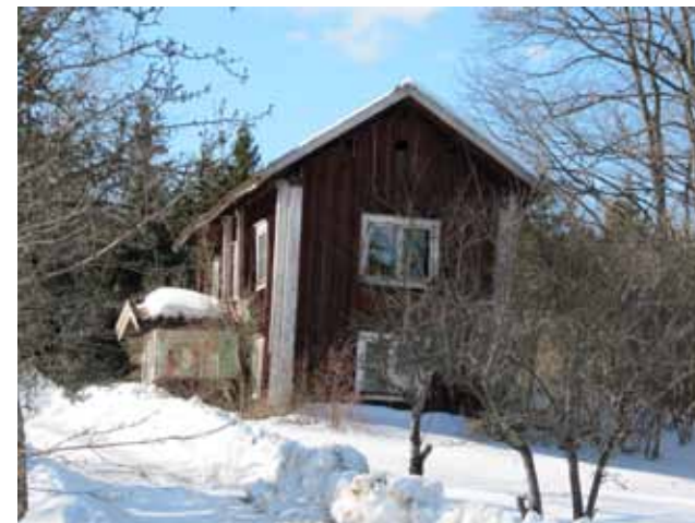
Tenntorps parstuga, ett 1700-talshus med en påbyggd övervåning från 1800-talet, därav de högsmala proportionerna. Timmerstommen märks genom knutlådorna.
