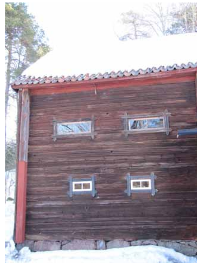
Timrat magasin från 1700-talet. Fönsteromfattningarna är av sen 1800-talstyp.
