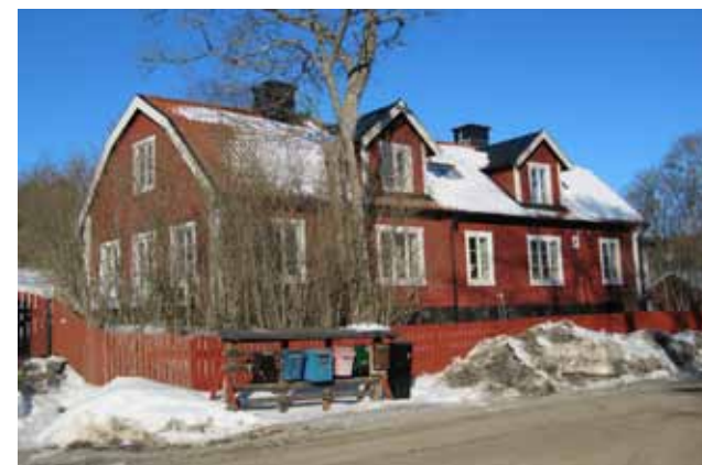
Arrendatorsbostaden har nästan en ståndsmässig framtoning med sitt brutna tak, medan den ordinära faluröda färgsättningen och avsaknaden av dekor markerar att huset har lägre status än herrgården.
