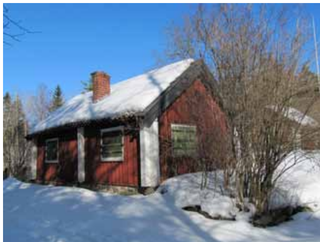
Klockarbostaden Snörom. De utstickande knutlådorna avslöjar en liggtimmerstomme och skorstenens läge långt ner på takfallet vittnar om en ålderdomlig takkonstruktion med långsgående åsar. Den låga grunden av natursten hör till äldre jordbruksbebyggelse före 1800-talets mitt.
