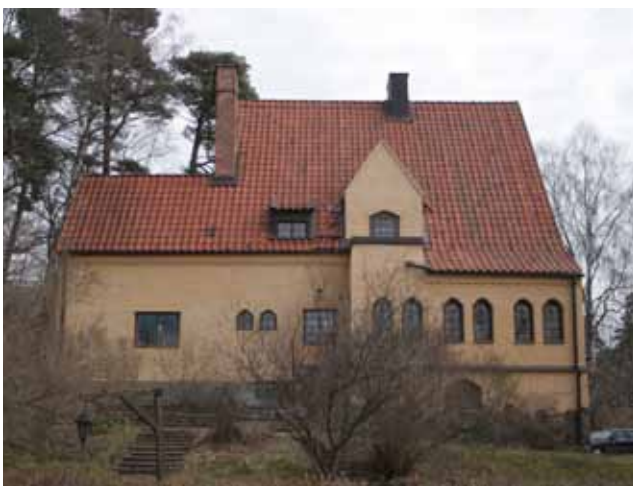
Nationalromantisk stenvilla från 1910-talet med tidstypiska drag som småspröjsade fönster och högt tegeltak. De tunga murarna och kyrkfönstren kan man även se hos villa Cajanus, se bild till höger.
