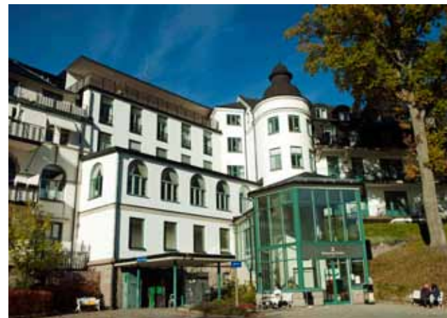
Saltsjöbadens sjukhus. Den äldsta delen (arkitekt G A Nilsson) byggdes 1903 som badhotell – "badanstalt" – med varmbad och olika gymnastik- och kroppsbehandlingar enligt det så kallade zanderska systemet (gymnastikapparater). Landstinget köpte badhotellet 1957.
