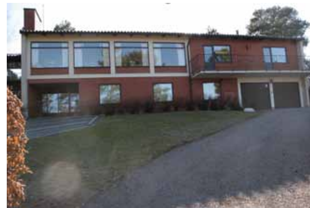
Villa från 1900-talets mitt med stora panoramafönster och olika material i fasad.
