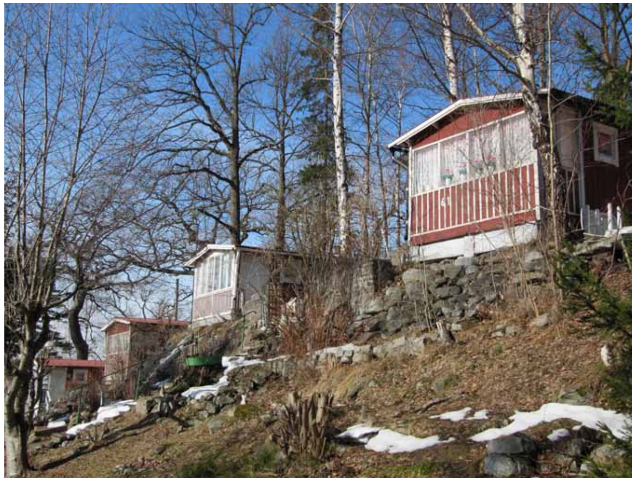
Omsorgsfullt kallmurade terrasseringar har gjort det möjligt att placera semesterstugorna i den branta terrängen. Stugan närmast i bild har synliga grundplintar. Uppvuxna buskar, träd och planteringar tillhör miljön.
