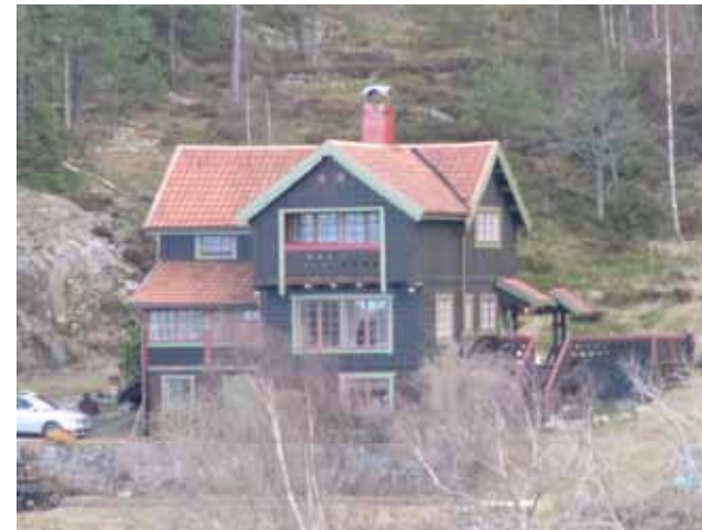
Dalens annex, nationalromantisk villa ritad av L I Wahlman 1902. De bonderomantiska dragen märks bland annat genom de breda vindskivorna och de små taksprången samt husets enkla, kraftfulla former.
