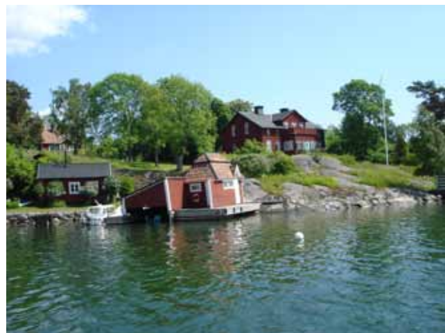
Gåsö Mellangård med huvudbyggnad från 1890-talet. Vid stranden ett badhus med tegeltak från omkring 1910, ihopbyggt med ett båthus på baksidan.
