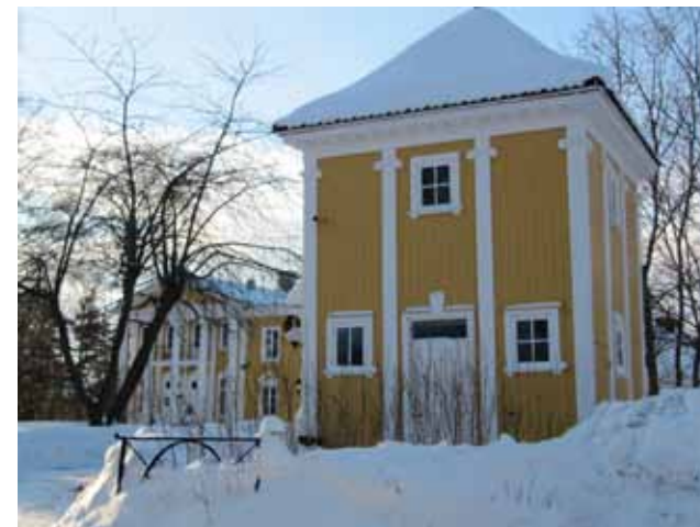
Almdalen, en herrgårdsvilla från omkring 1920, delar av stommen kommer från en 1860-talsvilla. Entrégrindarna kantas av ett porttorn. Arkitekturen är en lek med det tidiga 1800-talets klassicistiska stilströmningar.
