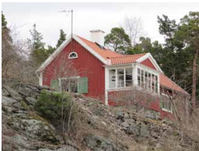
Sportstuga av bonderomantisk enkelstugetyp vid Älgövägen, möjligen ritad av Gunnar Lagerkrans. Utmed vägen ligger flera stugor av denna typ, uppförda i samband med vägens tillkomst på 1920-talet.
