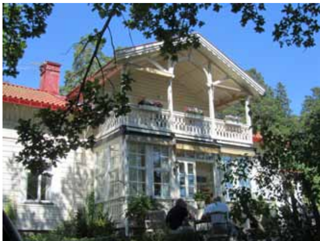
Östra Ekbacken, villa från 1860-talet som sedan 1931 tillhört Frälsningsarmén. Fasad mot Djurgårdsvägen. Villan är tillbyggd på baksidan.
