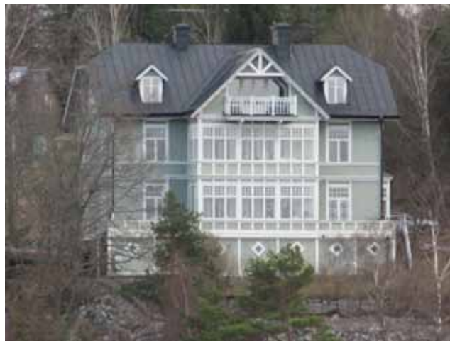
Herzogska villan vid Fågelsången, byggd 1905. Fönstrens indelning med småspröjsning i övre delen hör till byggnadstidens jugendarkitektur. För övrigt är huset en förenklad schweizerstilsvilla.
