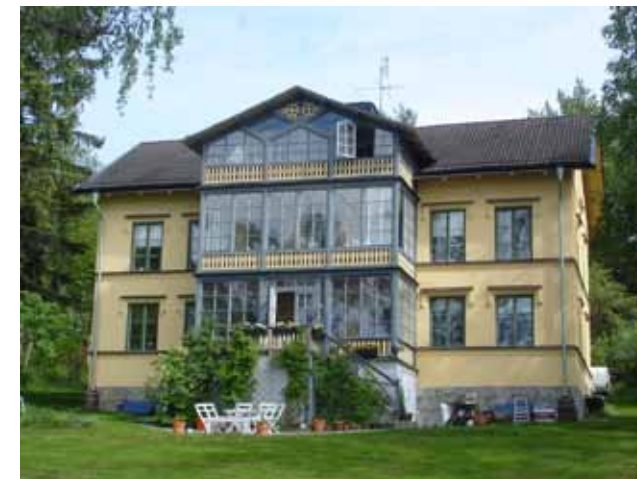
Stenhuset, Vikingshills enda stenbyggnad. Byggs redan 1865 som hyreshus för sommargäster. Kasernkaraktären, verandan undantagen, är ovanlig för hyresvillor. Bilden visar fasaden mot sjön.
