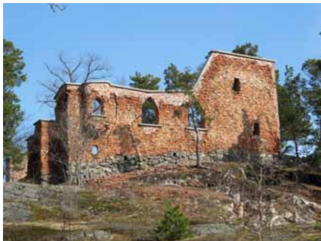
Grävlingbergsskansen med falska sprickor och gotiska fönster.
