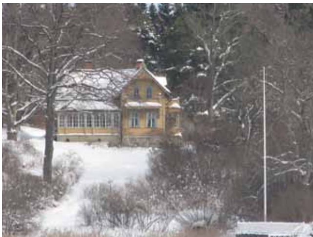
Parkvillan i Fredriksro. Cottagevilla från 1872 med en för stilen typisk högre sidoställd del.
