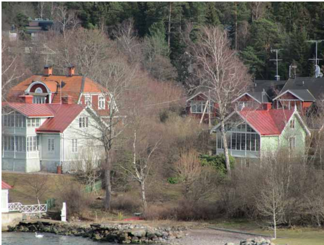
T.v. Gustafshäll vid Hasseludden, byggnadsminnesförklarad sommarvilla från 1860-talet. Glasverandan är osedvanligt påkostad med intrikata spröjsningar. T.h. Gustafshälls annex med stor glasad veranda.
