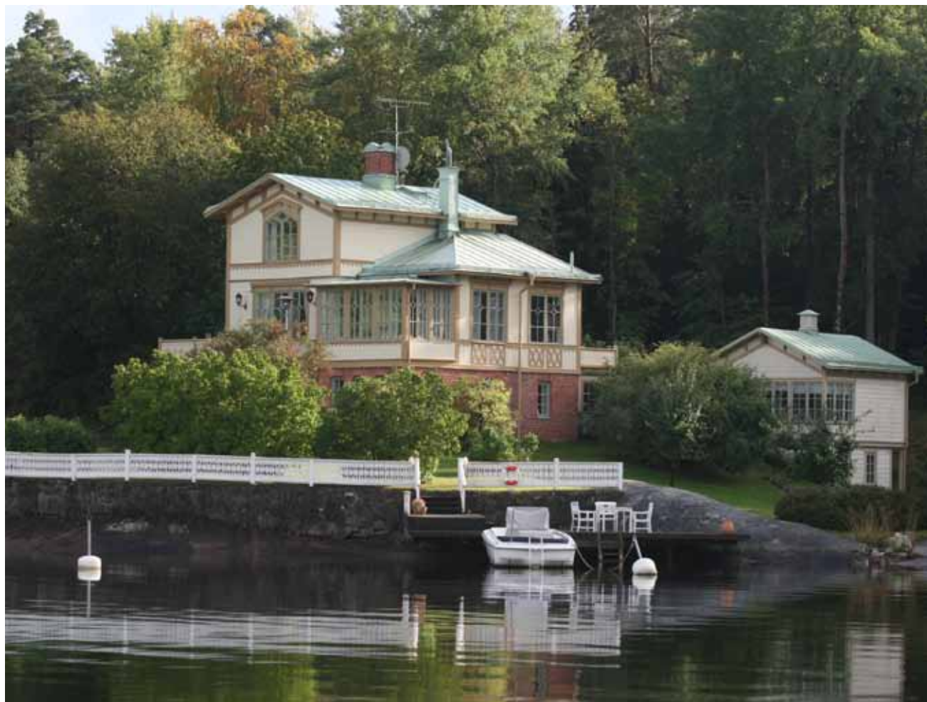
Sjövillan vid Fredriksro (Knarnäs), en sommarvilla i cottagestil från 1870-talets slut. Tegelsockeln gör den lite speciell. Villorna i Fredriksro – Skogsvillan, Parkvillan och Sjövillan – byggdes av den tyske bryggaren Fritz Dölling som här skapade en idyll för sin familj. Sjövillan var en bröllopspresent till dottern. Själv bodde han i Parkvillan.
