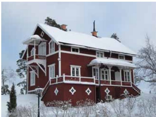
Bergshyddan, villa från 1880-talet med gavelbalkong. Huset ligger högst upp på en klippa med utsikt över farleden.
