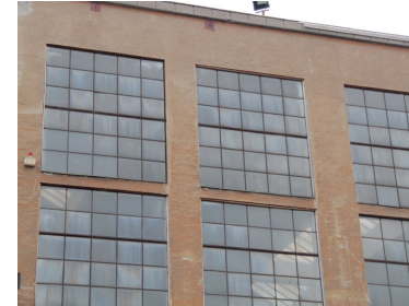
4) Detalj av svetshallsfasad från 1944.
