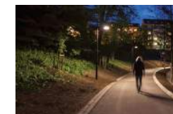
Nedåtriktat ljus på stolpe
