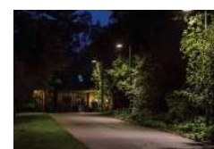
Nedåtriktat ljus på stolpe
