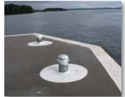
Figur 8. Kontrastmålning runt bryggdäck samt på och runt pollare.
