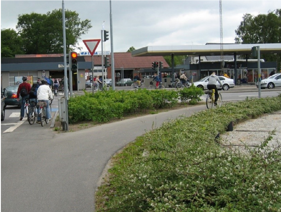
Figur 64. Exempel på utformning av fri högersväng för cyklister genom dragning av cykelbana bakom signalen.
