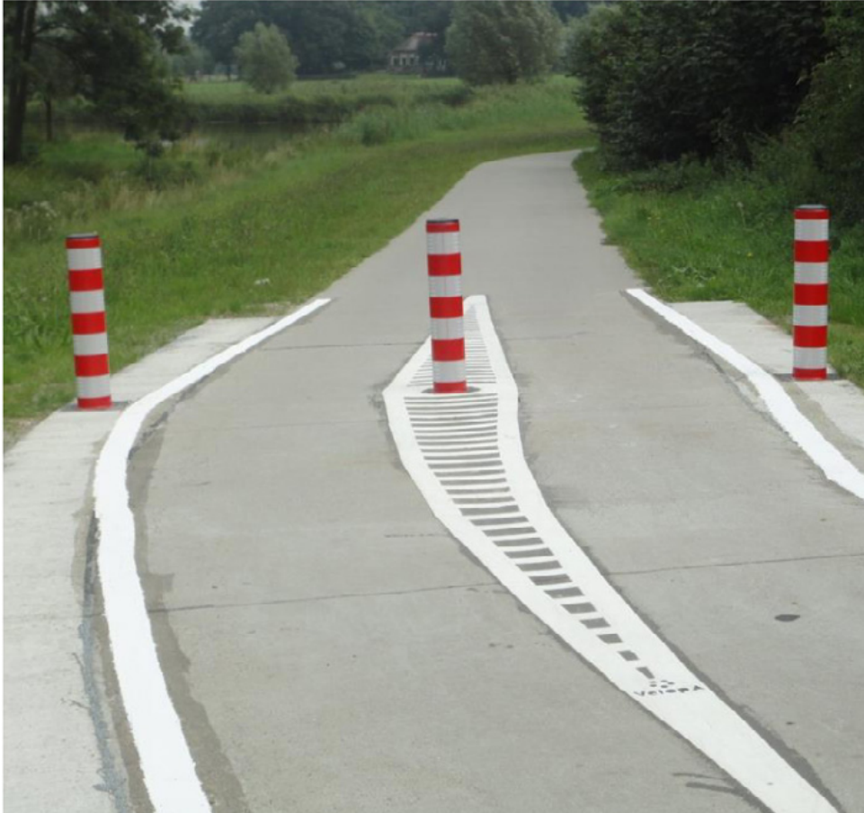
Figur 33. Exempel på utformning av bilhinder från Nederländerna. 63
