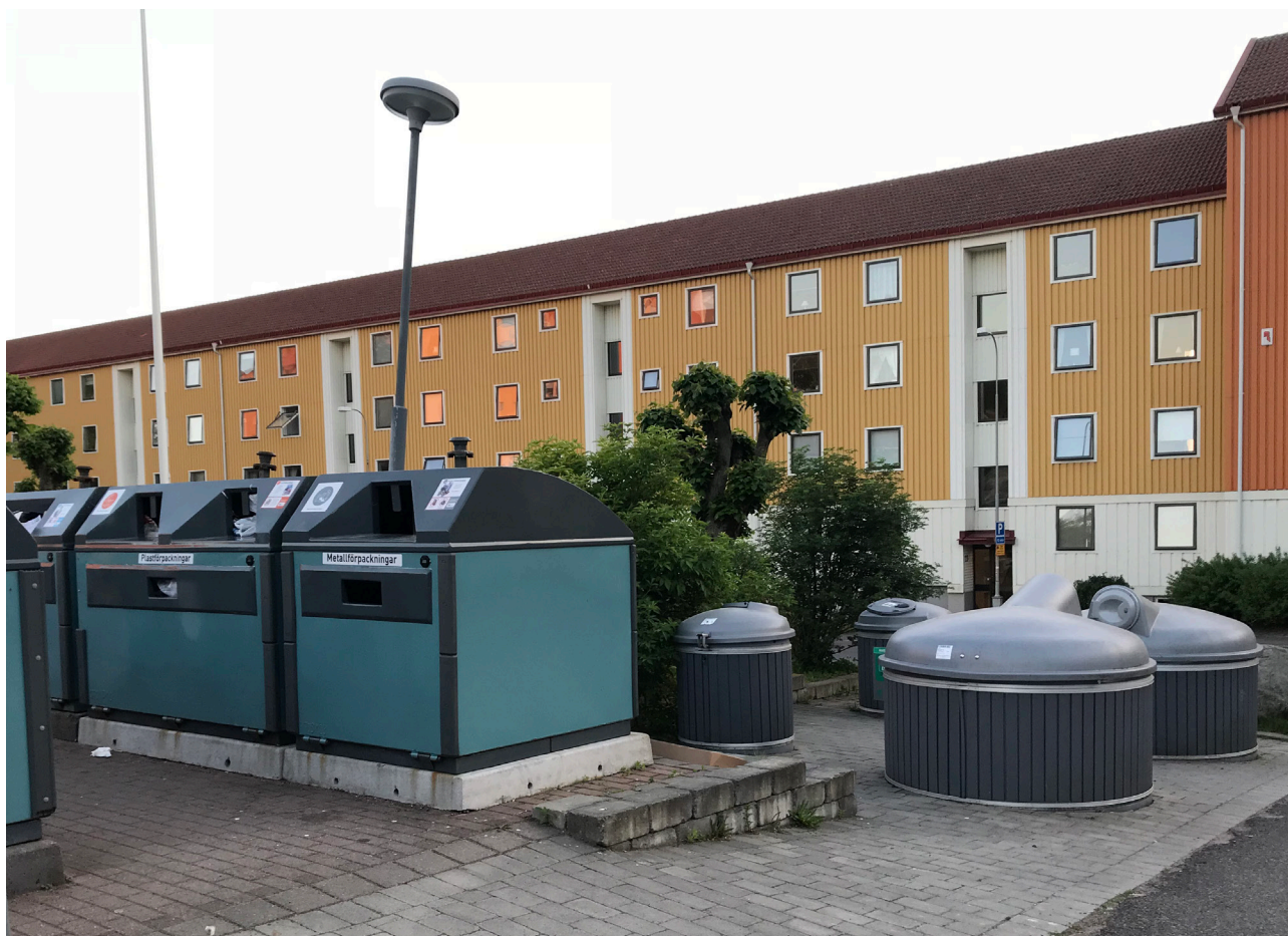
Bottentömmande behållare ovan mark och djupbehållare med insatssäck. FOTO: REBECCA JAKOBSSON, RAMBOLL.
